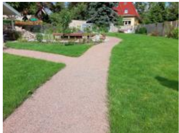
Abb. 4: Als Begrenzung zum Weg dient eine Metallborde. Der Splitt wird nie fest und so versinken die Räder ständig. Der Mäher steht immer schräg.
