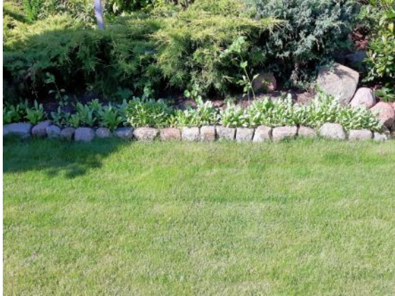
Abb. 7: Erhöhte Begrenzung mit Pflastersteinen.
