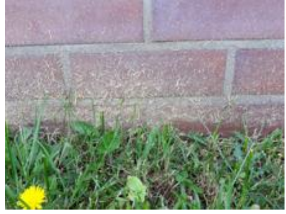
Abb. 6: Erhöhte Begrenzung mit Mauerwerk.
