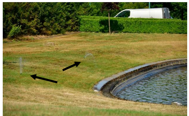
Abb. 4 Ergebnis mit einer automatischen Versenkberegnung [Anlage fehlerhaft]
