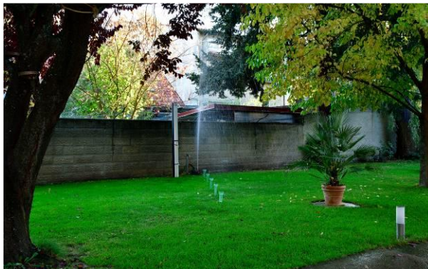
Abb. 9 Getrieberegner (Versenkregner)
